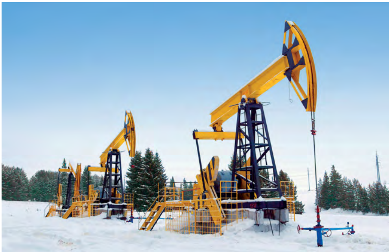
Станки-качалки на Мишкинском месторождении ОАО «Удмуртнефть»
