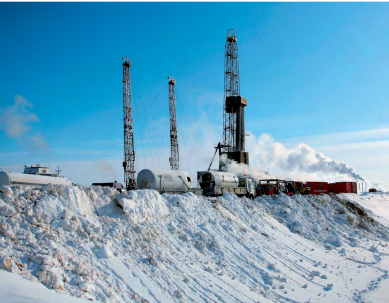
Буровая установка на кустовой площадке Приобского месторождения «РН-Юганскнефтегаз»
