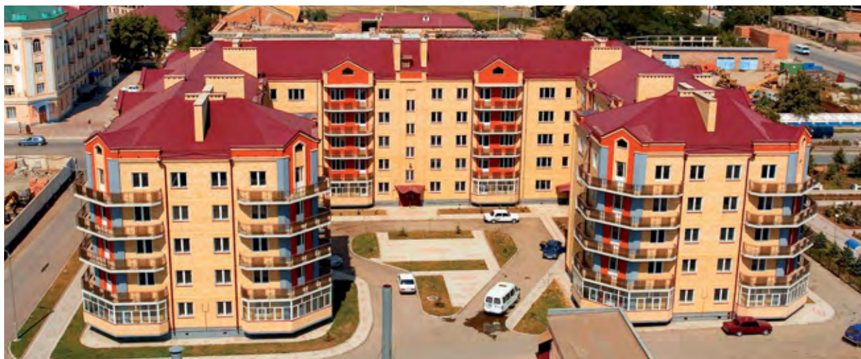
Новый дом, построенный для сотрудников ОАО «Грознефтегаз»
